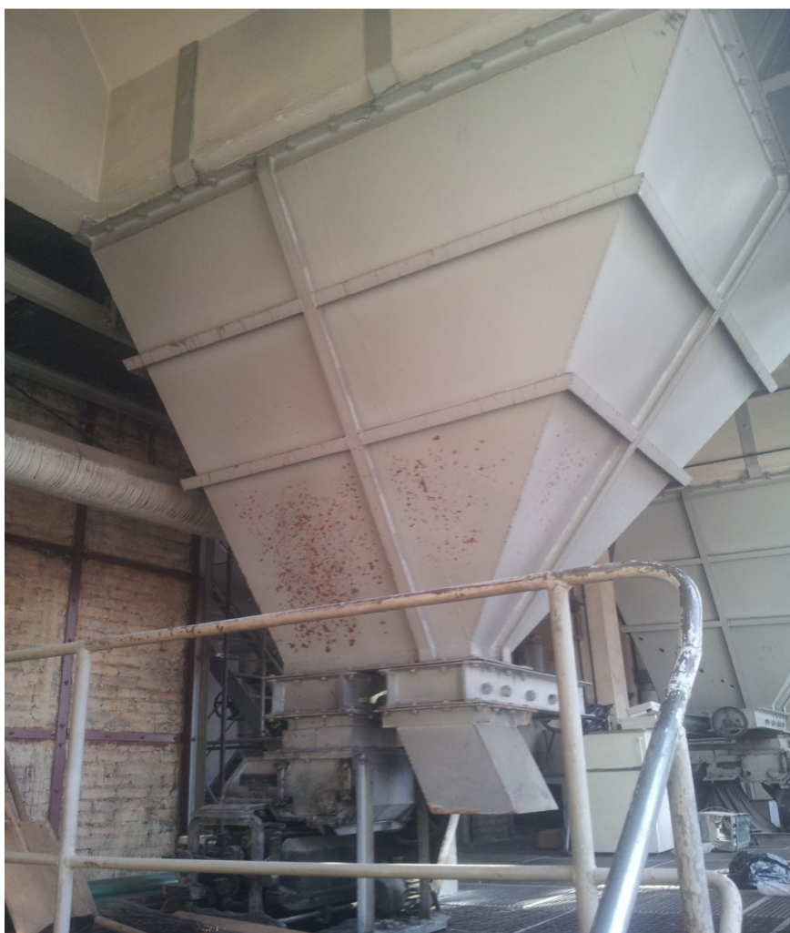
Zdjęcie nr 17 – podajnik do kotłów węglowych
