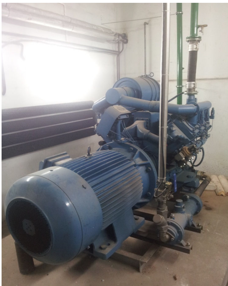
Zdjęcie nr 1 – sprężarka główna typu SFV6-125 o wydajności 600m 3 /h, na dalszym planie podłączenie sytemu chłodzenia.
