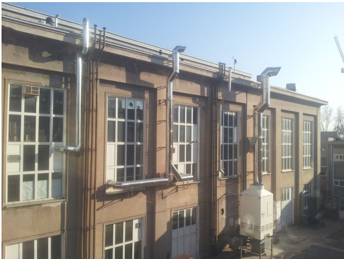
Zdjęcie nr 10 – ściana hali C, na zdjęciu widoczne kanały wentylacyjne, kominy spalinowe, jak i wyrzuty spalin
