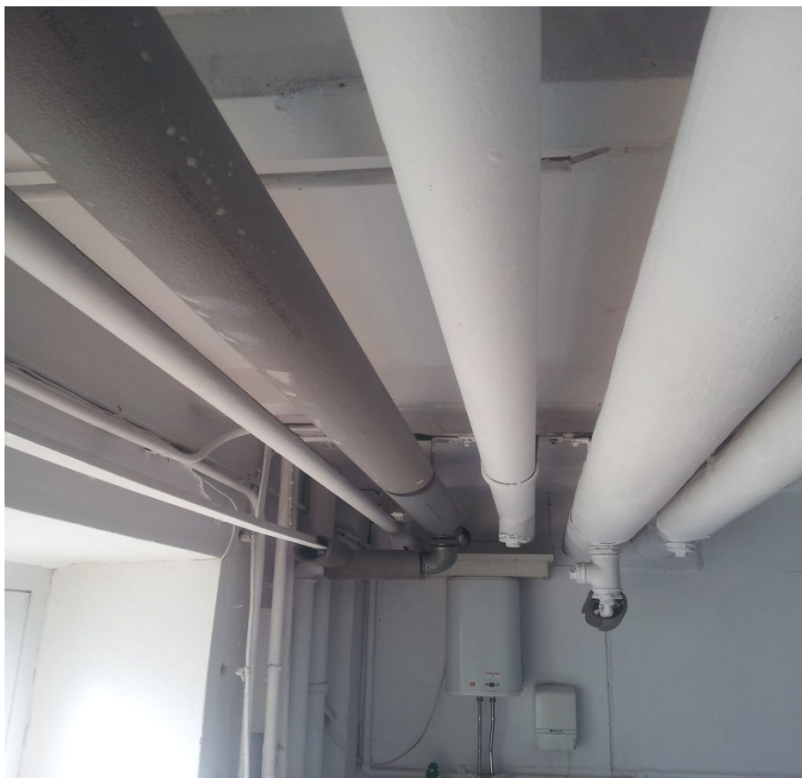
Zdjęcie nr 8 – sposób prowadzenia instalacji wodnych i sprężonego powietrza w hali C, na zdjęciu jedyną czynną instalacją jest woda w szarej otulinie, reszta to inst. nieczynne
