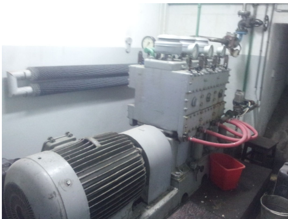
Zdjęcie nr 2 – sprężarka rezerwowa typu SE3-160A o wydajności 360m 3 /h.
