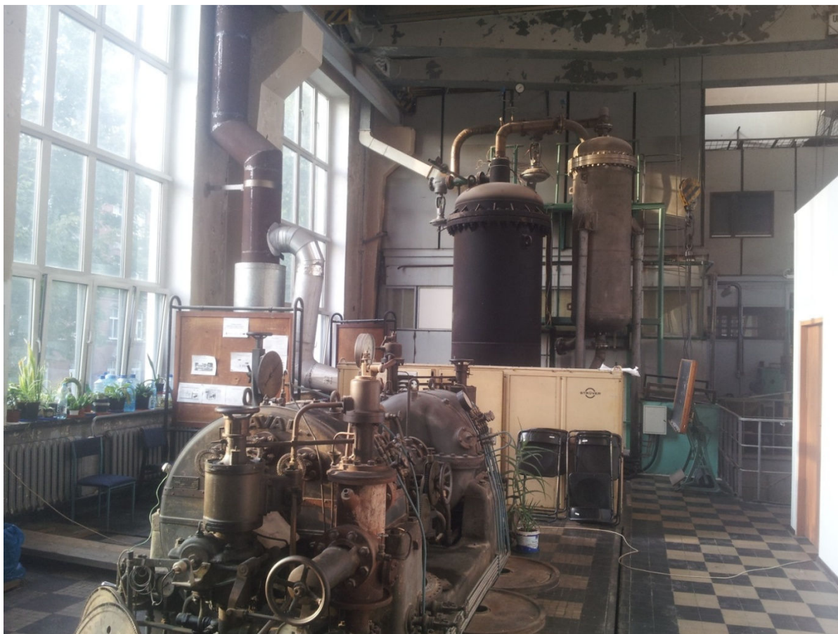
Zdjęcie nr 12 – na pierwszym planie widać turbinę Lavals, na końcu komora kotła fluidalnego oraz podłączony do niego odpylacz cyklonowy
