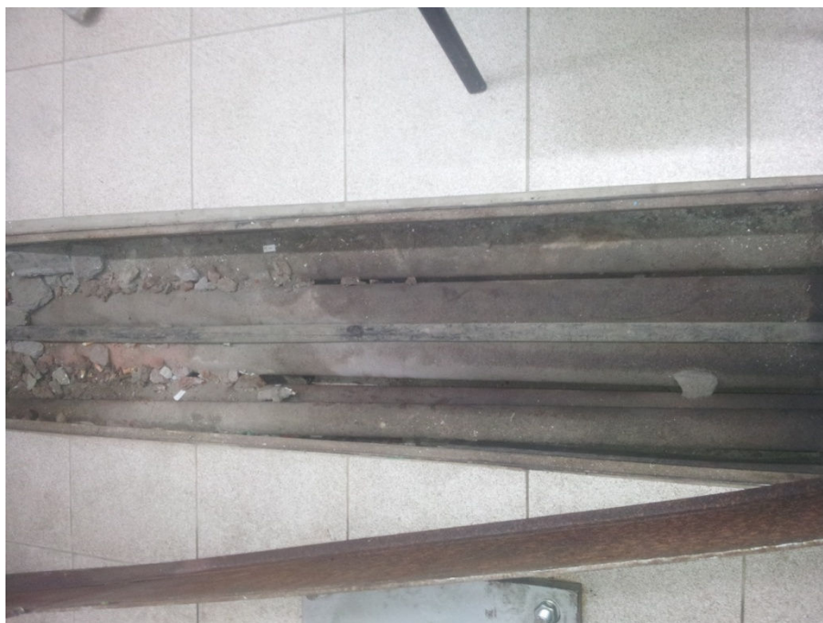
Zdjęcie nr 9 – stan instalacji spalinowych i wodnych w kanałach technologicznych
