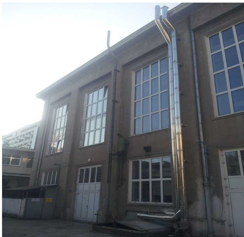
Zdjęcie nr 11 – ściana hali D, na zdjęciu widać kominy spalinowe oraz wyrzuty pary
