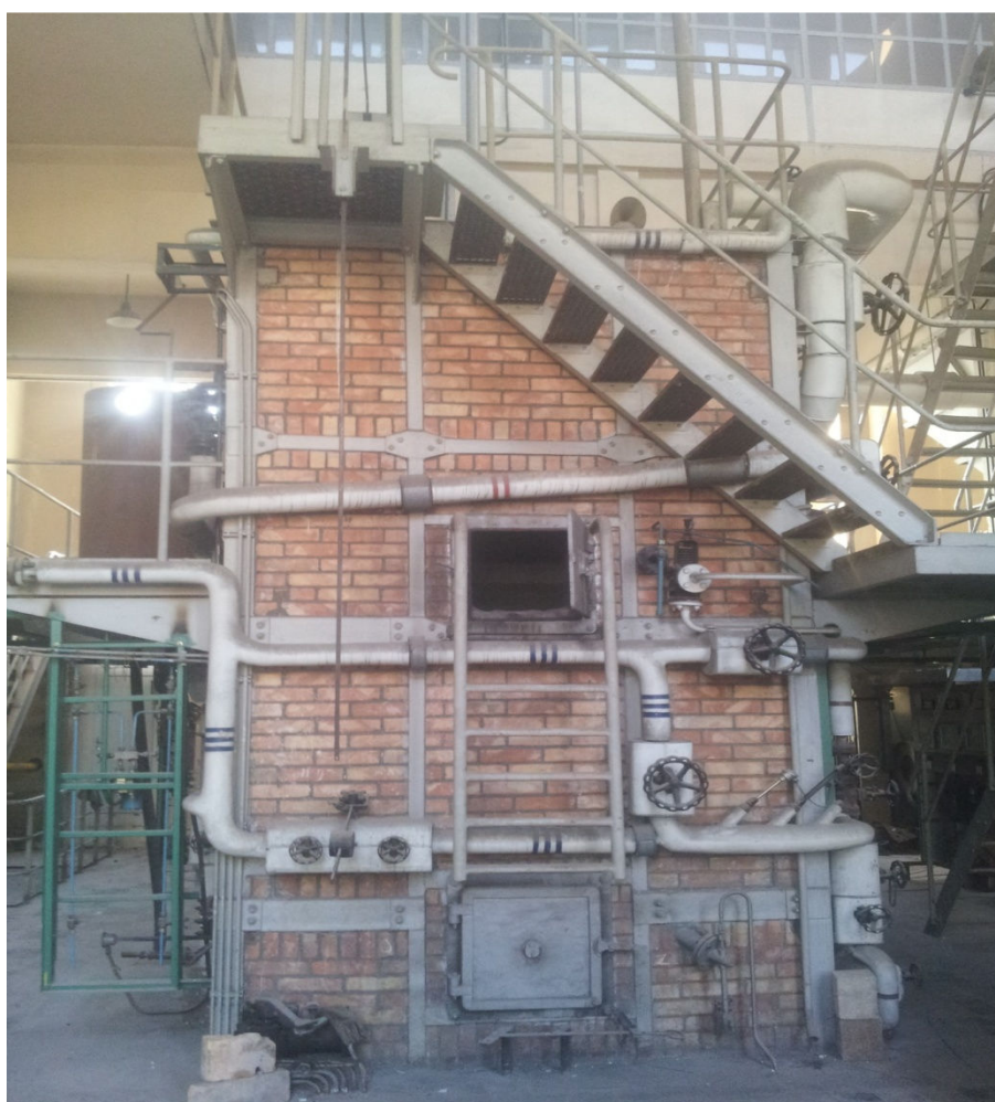
Zdjęcie nr 15 – kocioł węglowy nr 1 firmy EKM z przebudowanym paleniskiem fluidalnym
