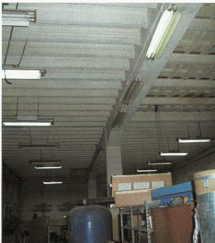
Fot. 5. Strop żelbetowy monolityczny hali w piwnicach budynku
