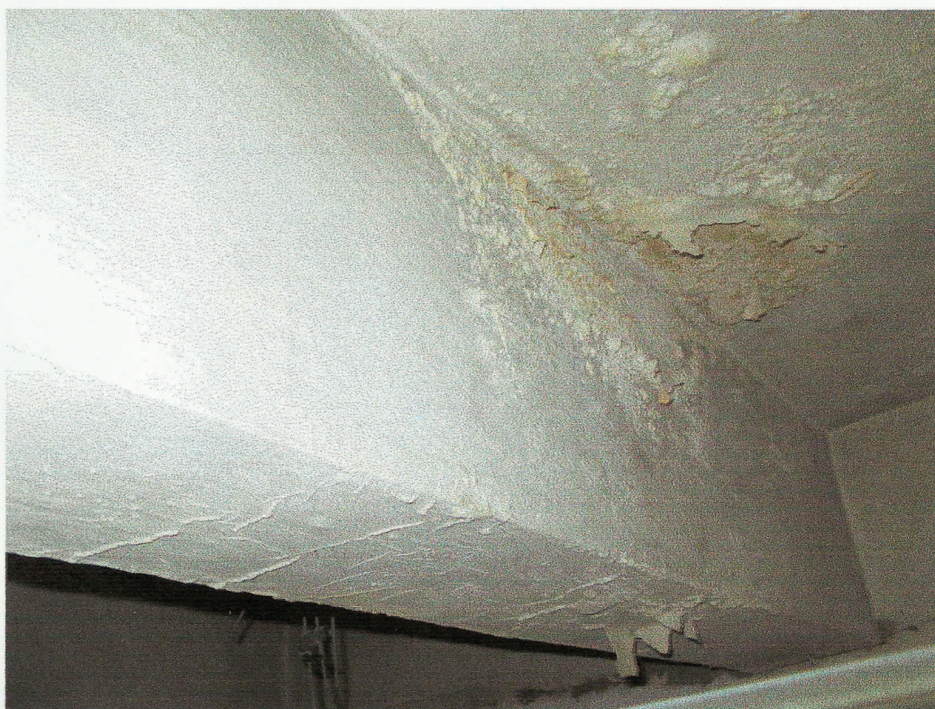
Fot. 10. Widoczne ślady zawilgocenia podciagu stropodachu – pomieszczenie A2
