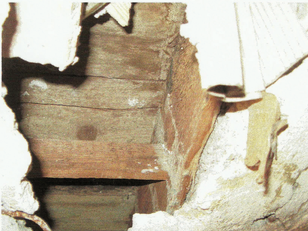
Fot. 7. Odkrywka stropu skrzynkowego w piwnicy – magazyn materiałów
