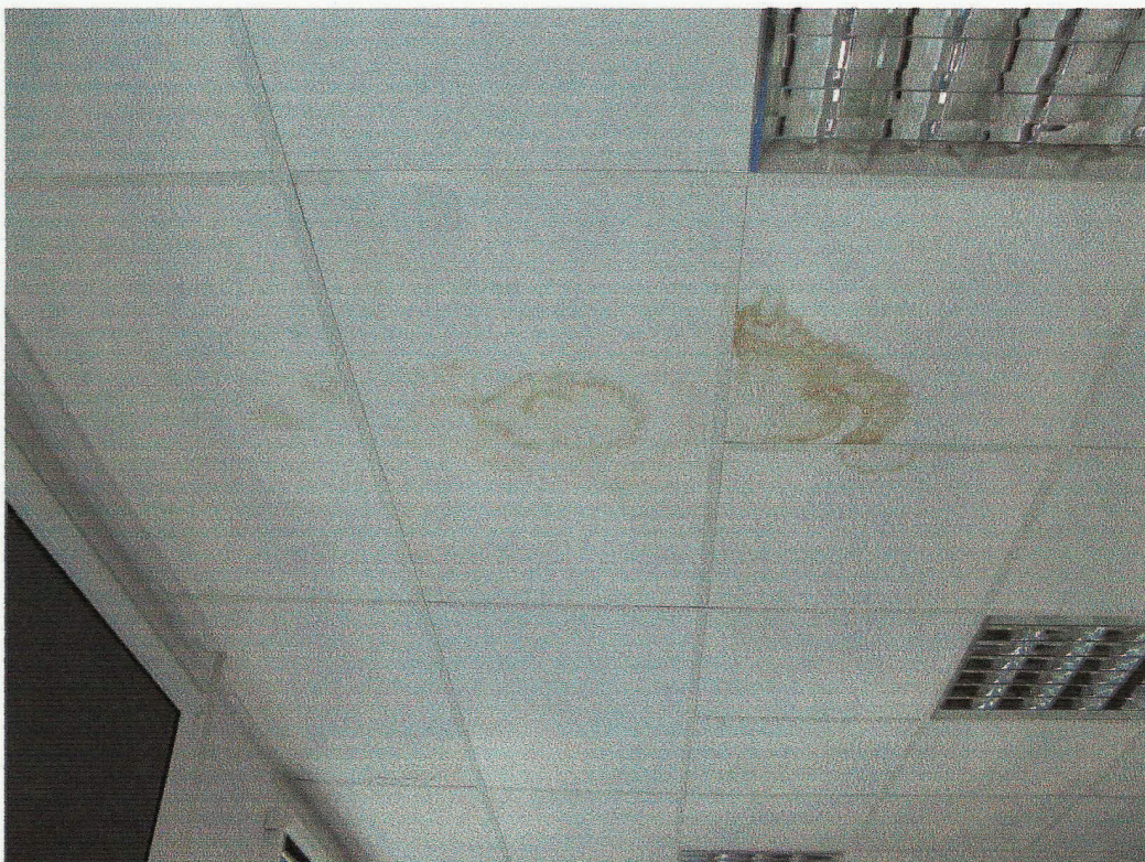
Fot. 9. Ślady zawilgocenia sufitu podwieszonego w pomieszczeniu A2
