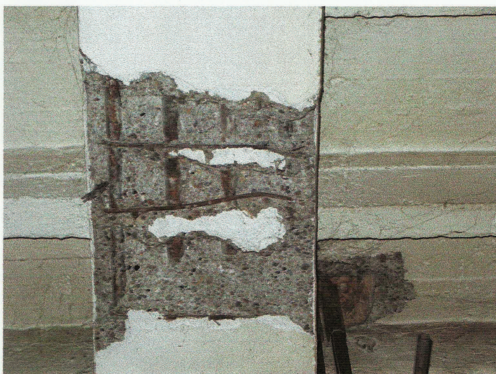
Fot. 6. Widok zbrojenia głównego i strzemion w głównym podciagu ww. stropu
