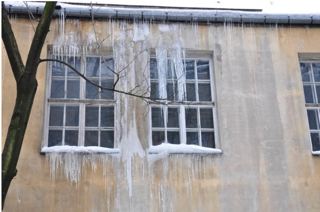
Uszkodzenia tynków w wyniku zawilgocenia wodami opadowymi.
