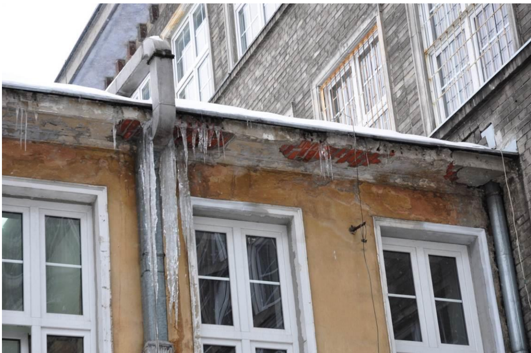
Uszkodzenia gzymsu na skutek niesprawnego systemu odprowadzania wód opadowych.
